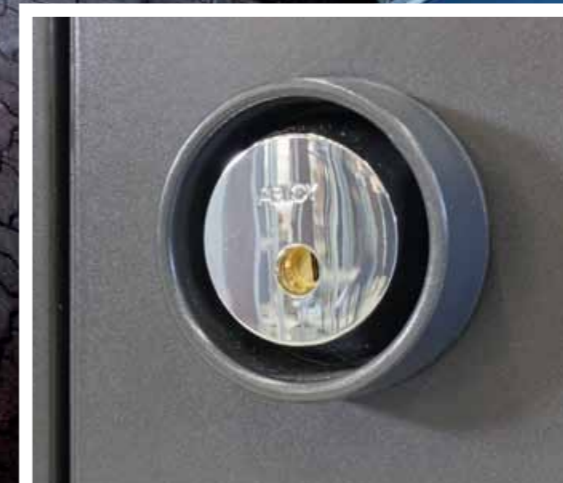
Lukon suojarahkki estää murtautujaa pääsemästä käsiksi lukkopesään.
